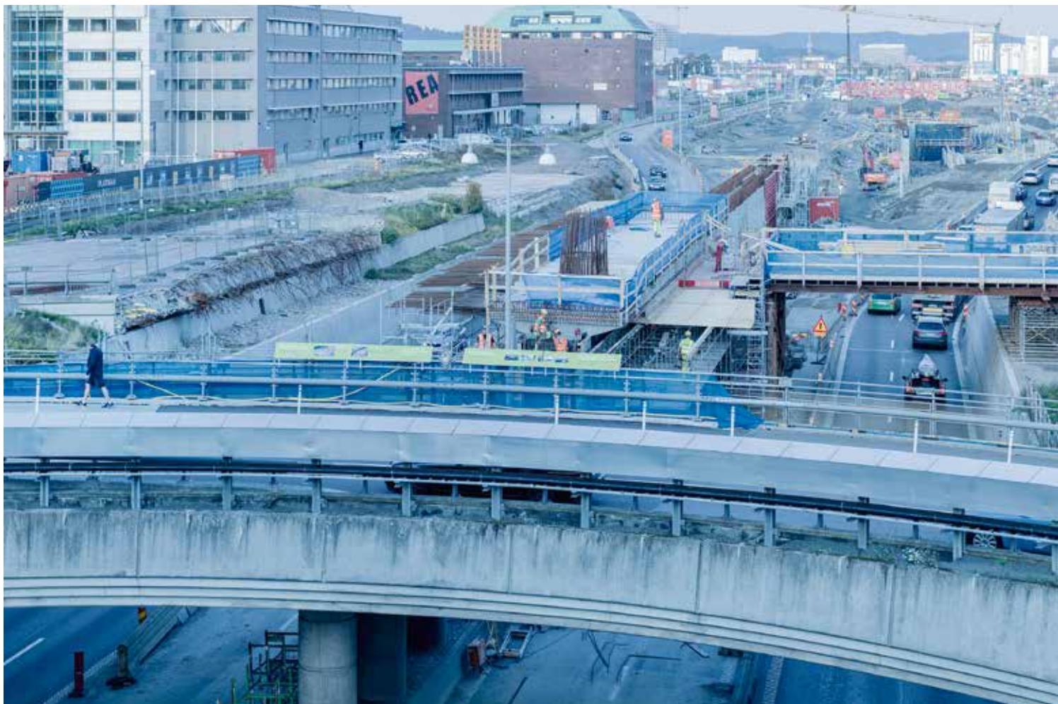
STÖKIGT. Området runt centralstationen är bara en av alla platser där göteborgarna får vänja sig vid byggkranar, lastbilar och omlagda vägar.
